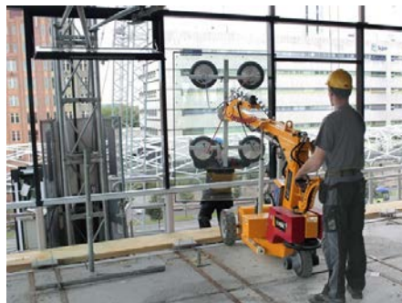
Es. di dispositivo di sollevamento a ventosa Montaggio lastre con robot dotato di braccio a sollevamento telescopico e ventose
